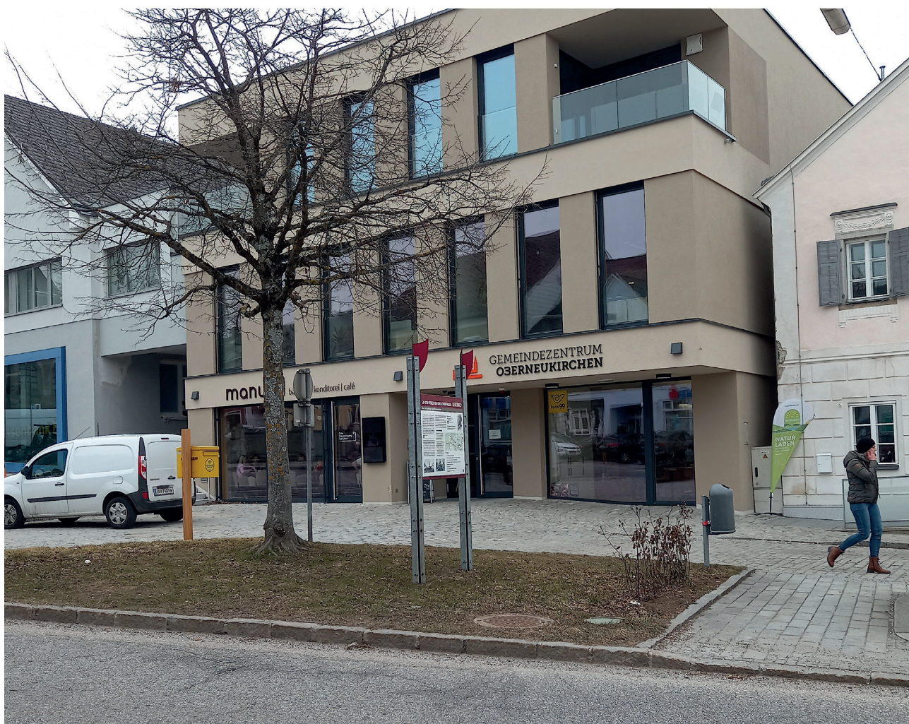
Im Gemeindezentrum Oberneukirchen sind das Gemeindeamt, ein Cafe und Wohnungen untergebracht.
